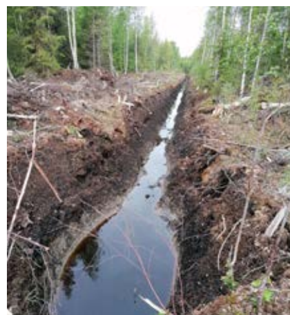
DIKE MED SLAMGROP: Slamgropar grävs med jämna mellanrum i hela dikesnätverket och syftar till att samla upp fast substans det första året efter rensningsarbetet. Dikesrensning görs bara där det verkligen behövs. Slamgroparna bör kompletteras med ytterligare vattenvårdskonstruktioner för tillräcklig effekt.
