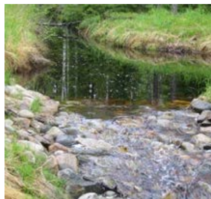
BOTTENDAMM: Med hjälp av olika slags bottendammar kan vi bromsa vattenflödet och minska erosionsproblemen.
