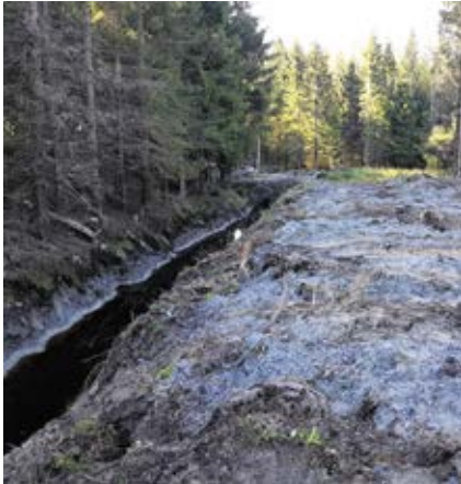
Utjämnad dikesvall längs rensat utfall i Replot. Här är det lätt att köra vid nästa avverkning eller utfallsrensning. Foto: John Berg
